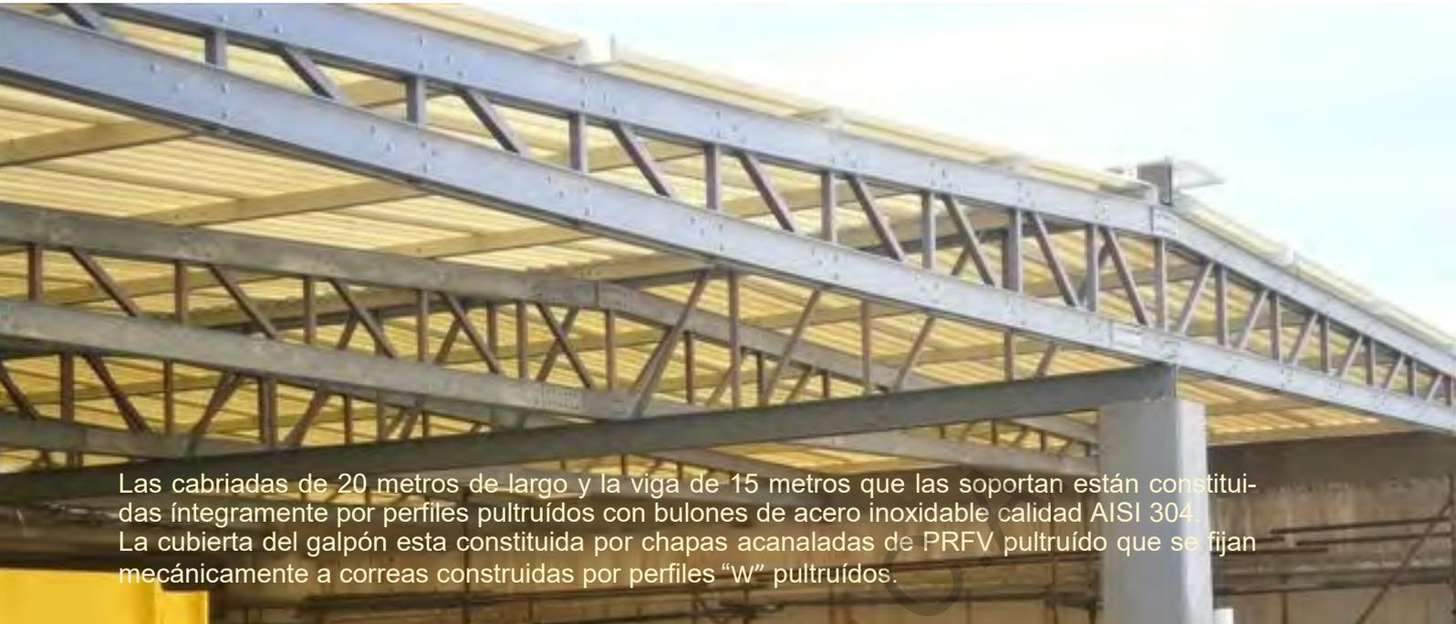
Las cabriadas de 20 metros de largo y la viga de 15 metros que las soportan están constituidas íntegramente por perfiles pultruidos con bulones de acero inoxidable calidad AISI 304. La cubierta del galpón esta constituida por chapas acanaladas de PRFV pultruido que se fijan mecánicamente a correas construidas por perfiles "W" pultruidos.
