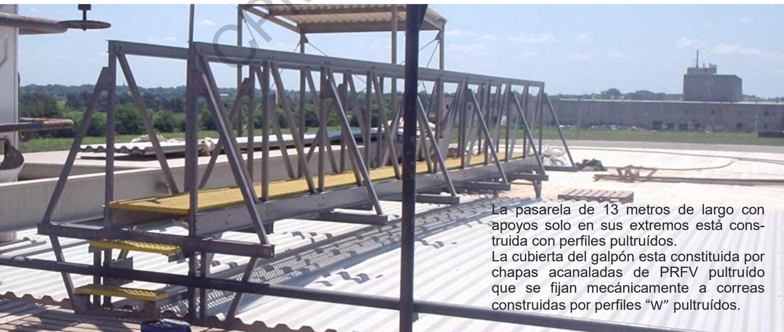
La pasarela de 13 metros de largo con apoyos solo en sus extremos está construida con perfiles pultruidos. La cubierta del galpón está constituida por chapas acanaladas de PRFV pultruido que se fijan mecánicamente a correas construidas por perfiles "W" pultruidos.
